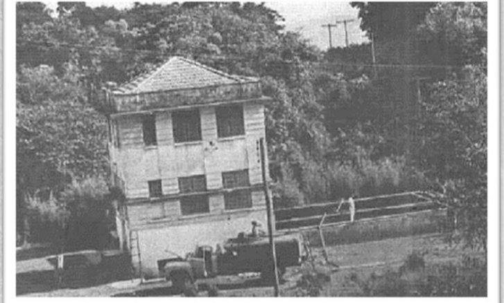
Casa da Química, atual Biofábrica (Parque das Mangabeiras)
