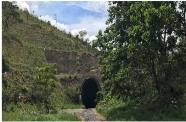
Túneis da Ferrovia do Aço
